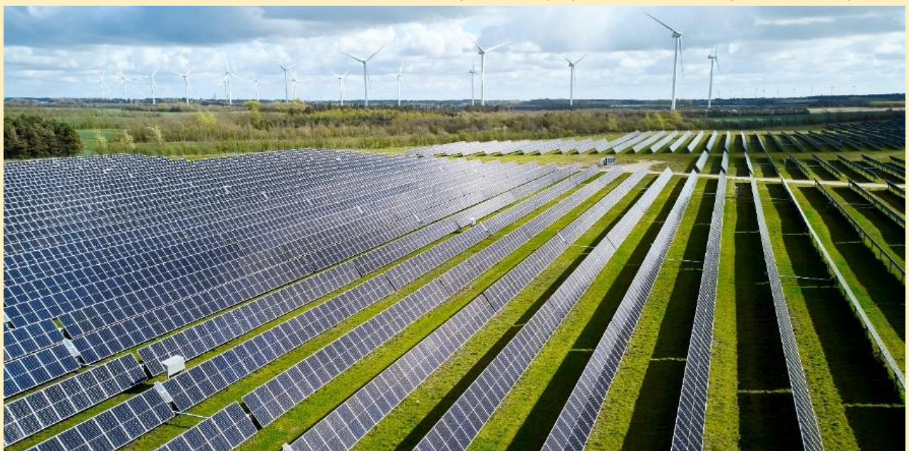
TRANSFORMERSTATION OG TEKNIKBYGNINGER Figur 2: Eksempel på bunddække under og imellem solcellepaneler.
